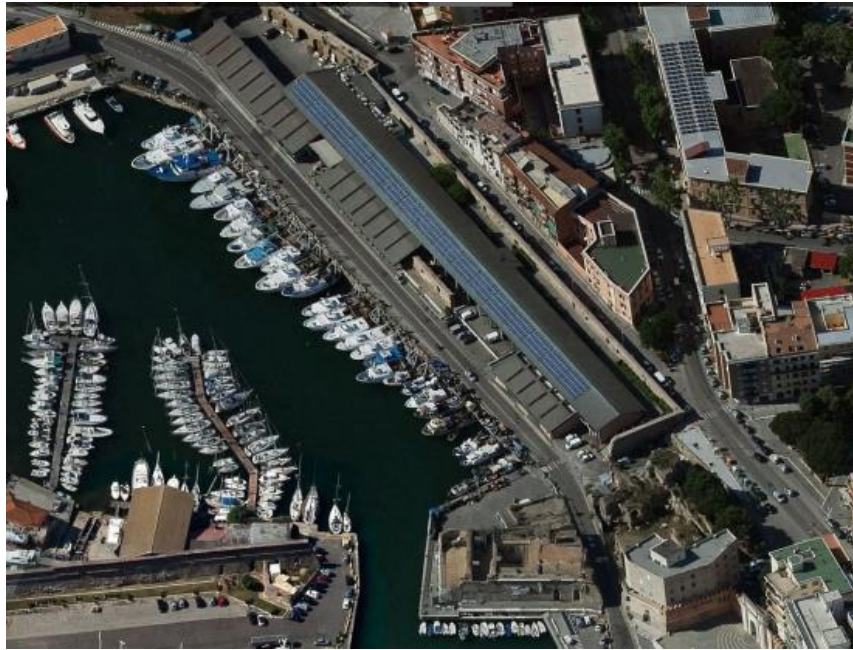
Impianto PV Darsena Romana
