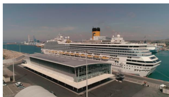
Impianto PV RCT "Amerigo Vespucci"
