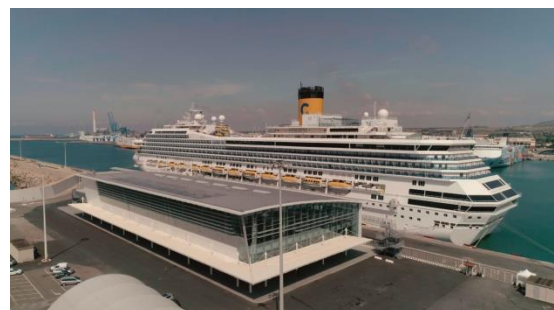
Impianto PV RCT "Amerigo Vespucci"
