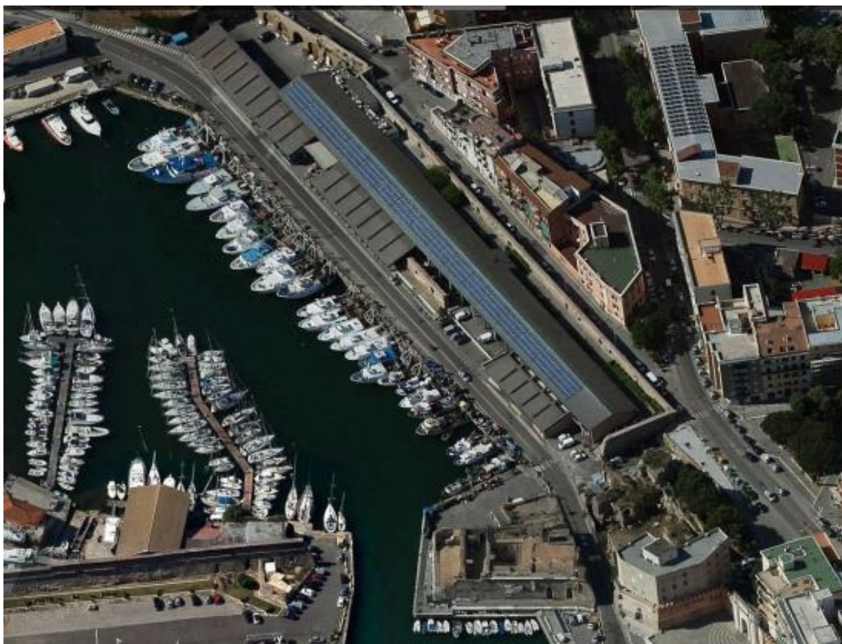
Impianto PV Darsena Romana
